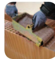
**Le joint horizontal** est constitué de mortier Joint Mince. Il est mis en œuvre à l'aide du rouleau applicateur Joint Mince. Cet outil dépose le mortier uniquement sur les parois en terre cuite de la brique. La dépose du mortier Joint Mince s'effectue en "tirant" le rouleau. Avant application du mortier, procéder à un dépoussiérage à la brosse humide.
