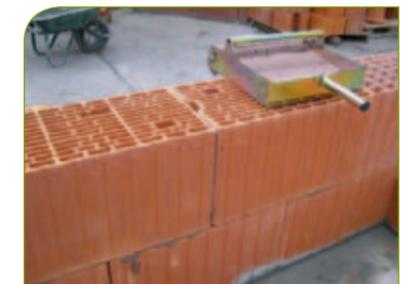
**2** - Pose de la brique **bgv'S25** à l'aide du rouleau applicateur. Mise en œuvre partie courante p 30
